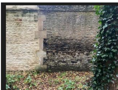
Mur écroulé et reconstruit
